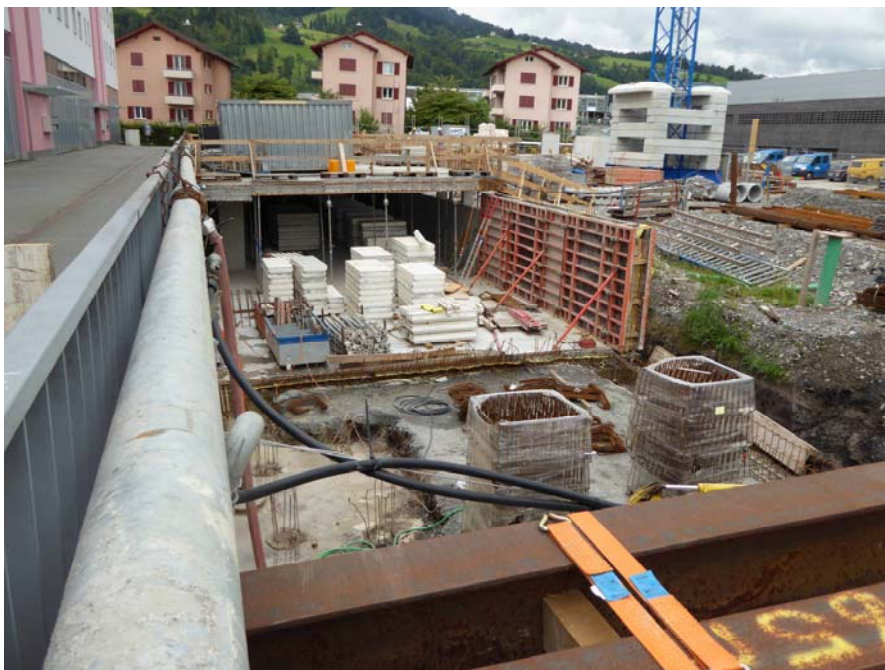
Anschluss neuen an die bestehende Einstellhalle
