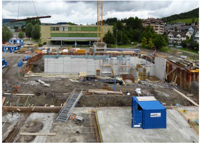
Zweigeschossige Wände der Bibliothek
